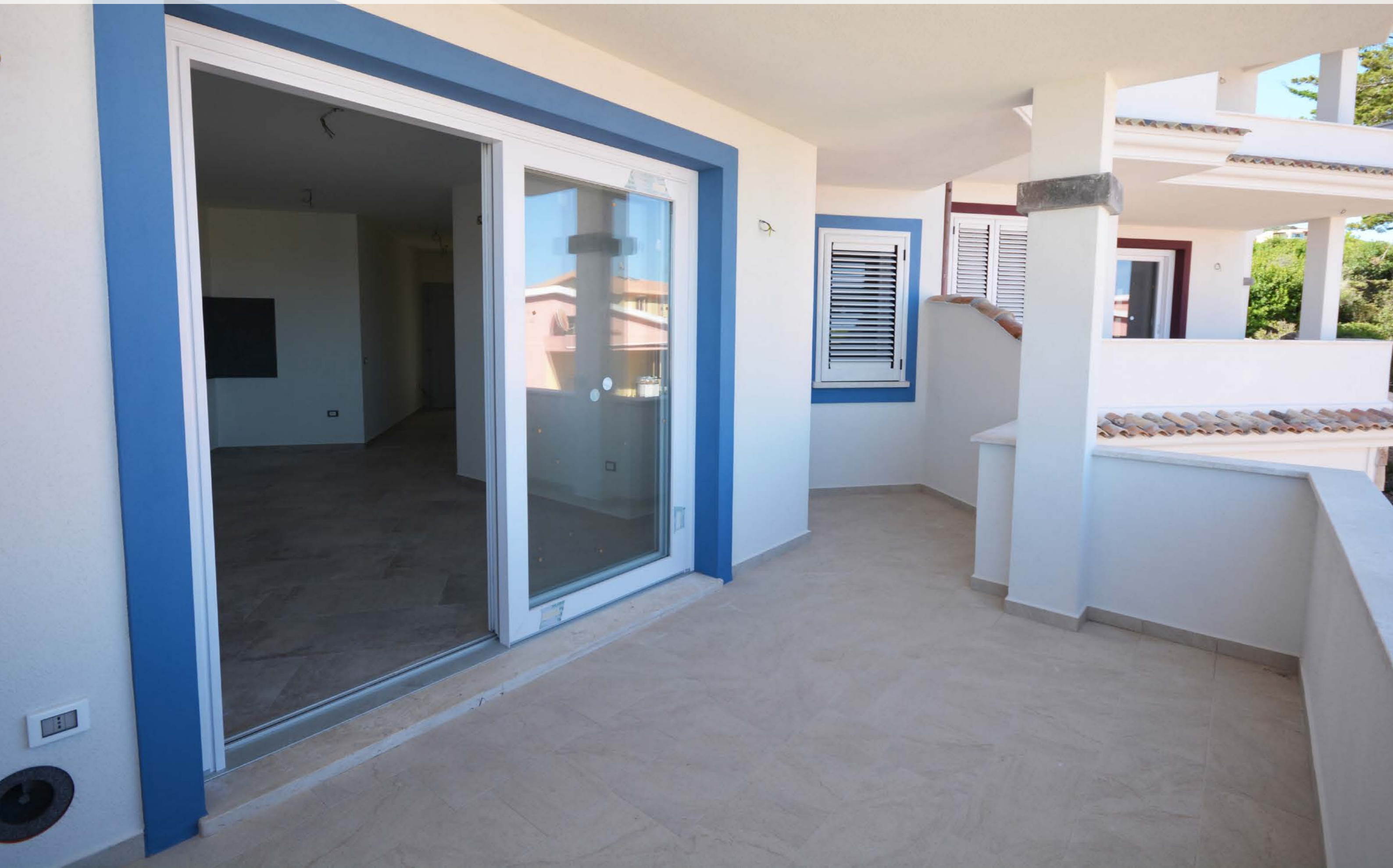
Veranda coperta Vista Mare
